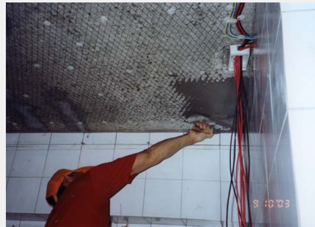
4.面層低電阻水泥砂漿鏝抹
