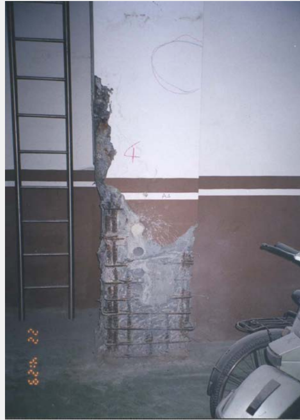
使用含高氯離子修補材料造成柱端混凝土的剝落及鋼筋腐蝕
