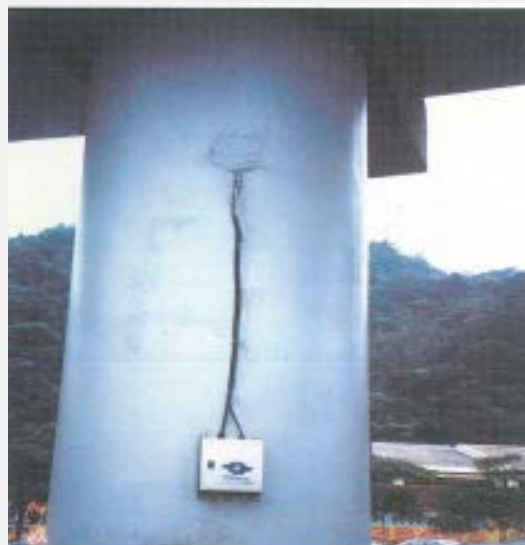
5.偵測箱安裝完成(一)
