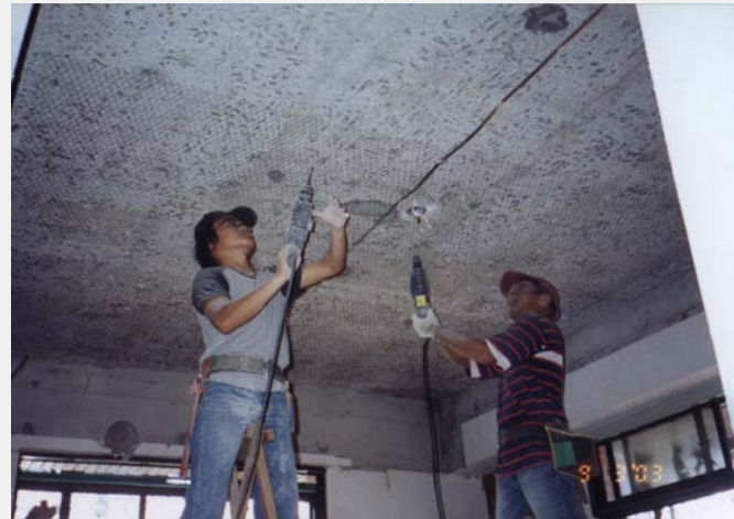
3.電極及防蝕系統安裝
