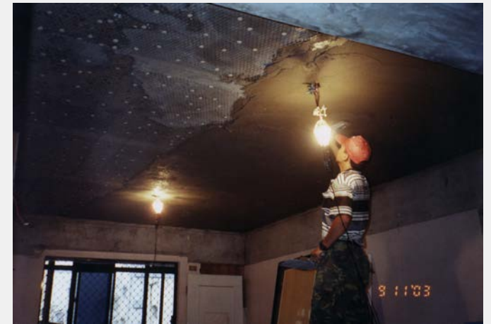
5.面層低電阻水泥砂漿鏝抹
