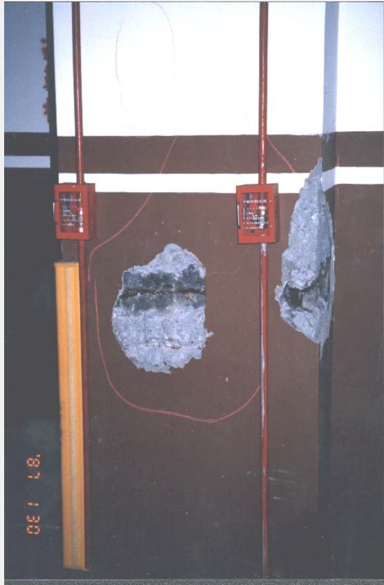
使用含高氯離子修補材料造成柱端混凝土的剝落及鋼筋腐蝕
