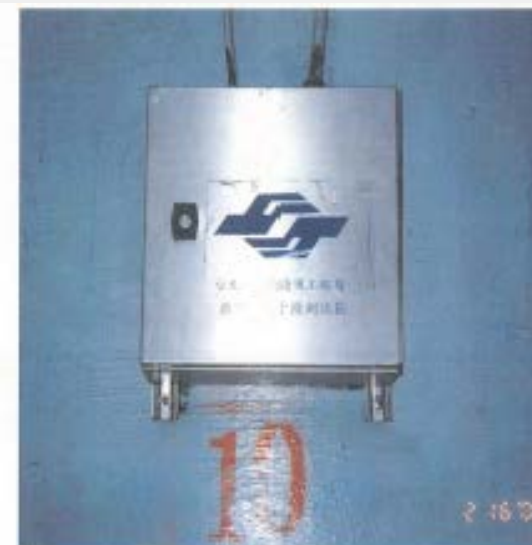
6.偵測箱安裝完成(二)
