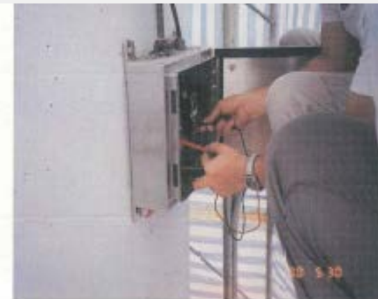
4.雜散電流電位量測
