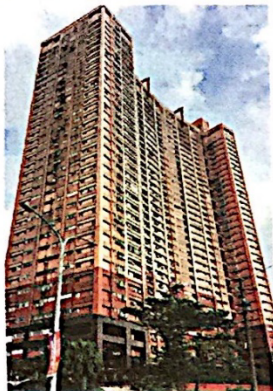
■張家在江山萬里大樓3樓，污水管線堵塞，馬桶噴糞水。吳珮如攝
