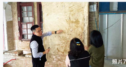
構造隱蔽處規劃期間無法調查，施工拆解後與營造廠研議對策。照片為現場麻絨灰漿層剝除後發現磚牆有植入木樁的作法，較為少見。
