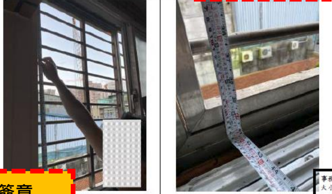
編號 7 陽台違建 編號 8 陽台違建:已留設開口高度 121cm
