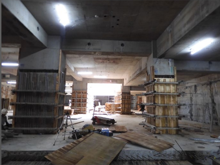
H棟B1F二次柱牆結構體施工 2021.10.19
