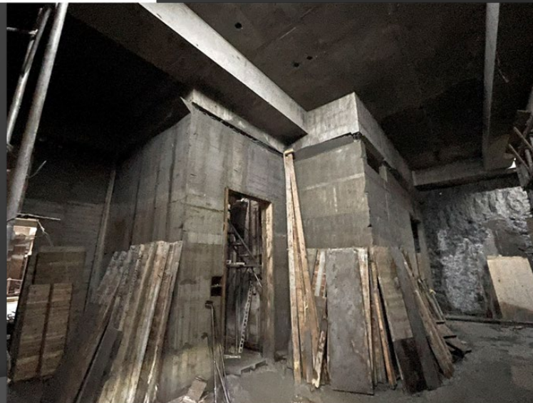
H棟B2F二次柱牆施工 2022.03.01
