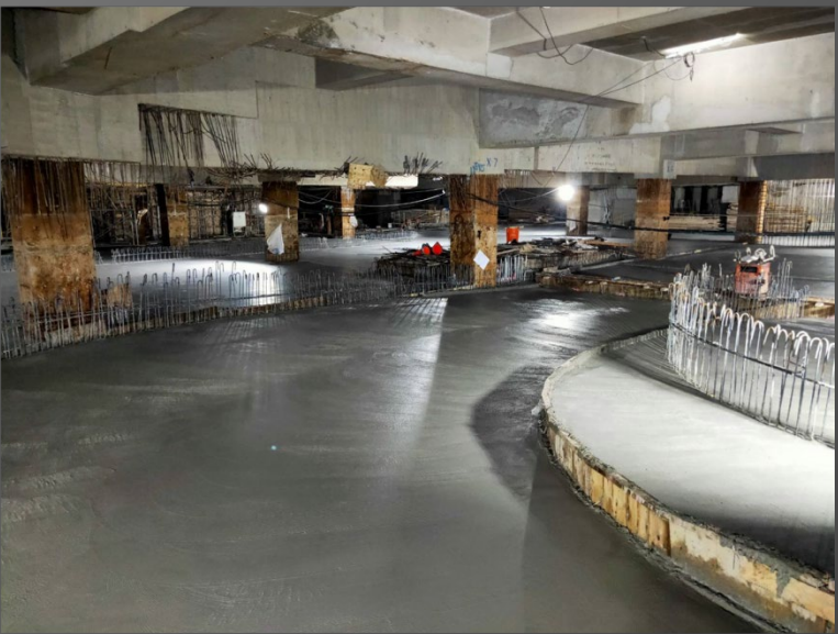
B棟B1F北區混凝土打設粉光完成 2021.11.06
