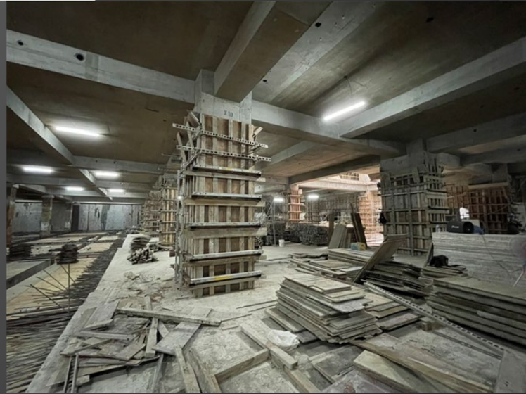
D棟B2F二次柱牆施工 2022.05.06
