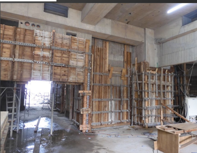
D棟B2F北側二次柱牆施工 2022. 04. 21
