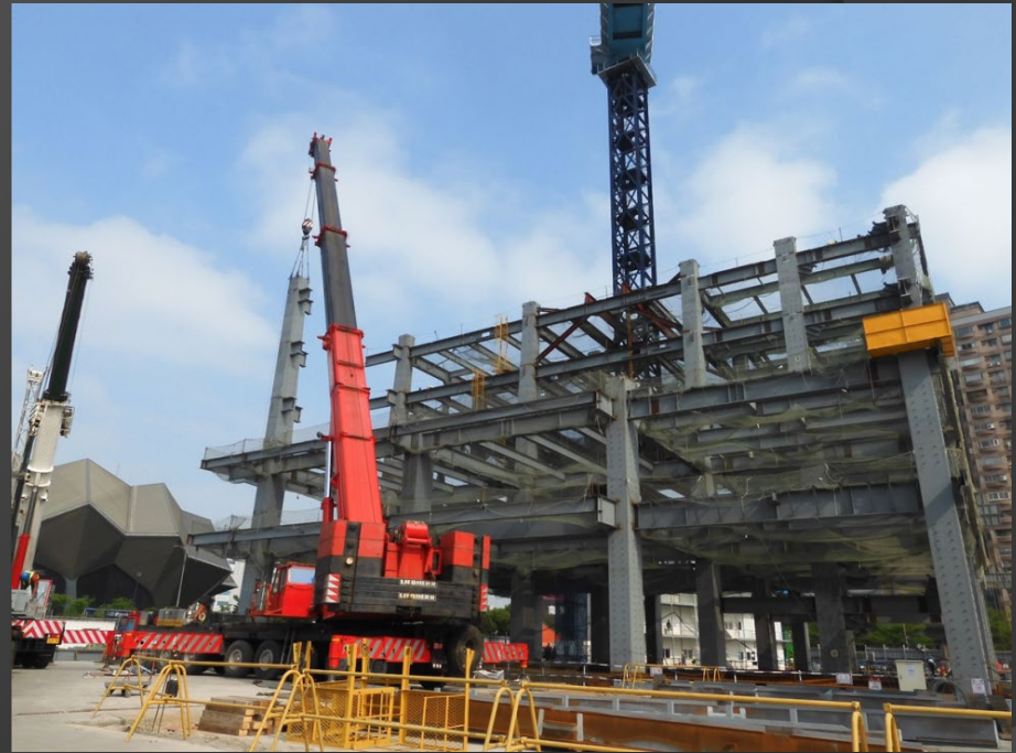
各區鋼構第一.二節吊裝
