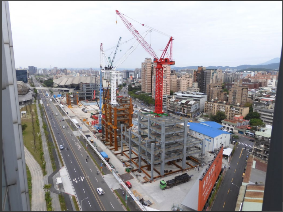
塔吊安裝及遮斷層DECK設置
