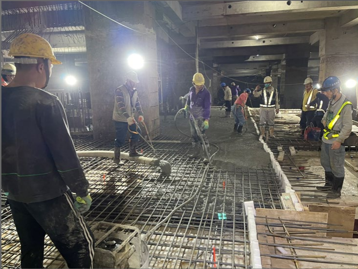
C棟B2FL北側灌漿作業 2022. 02. 15
