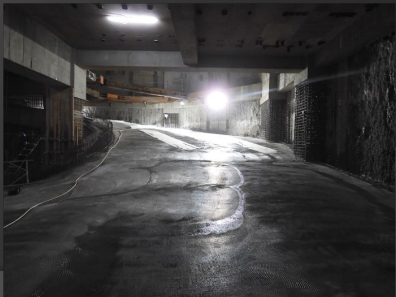
G棟B2F北側車道灌漿後養生 2022.04.29
