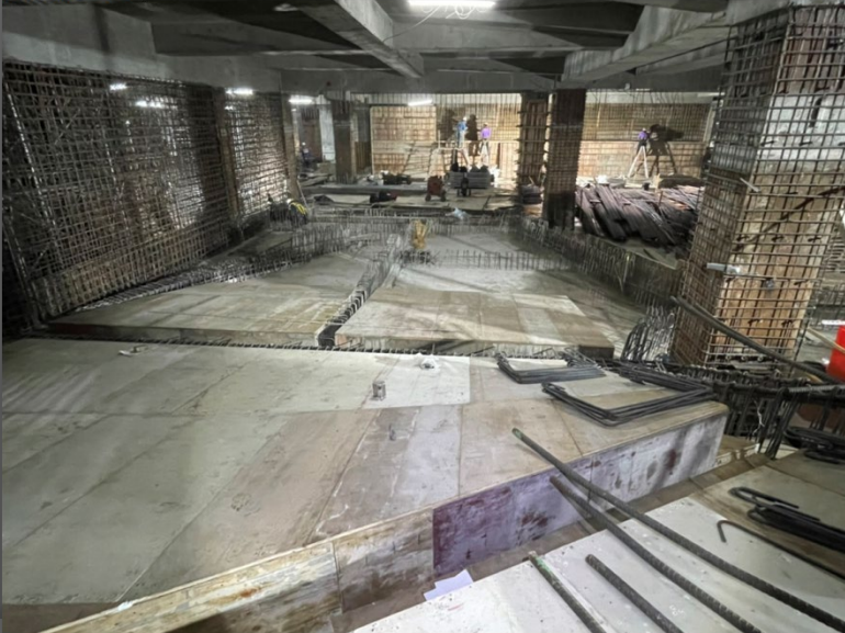
B棟B2F北側車道版模板組立 2022.02.21
