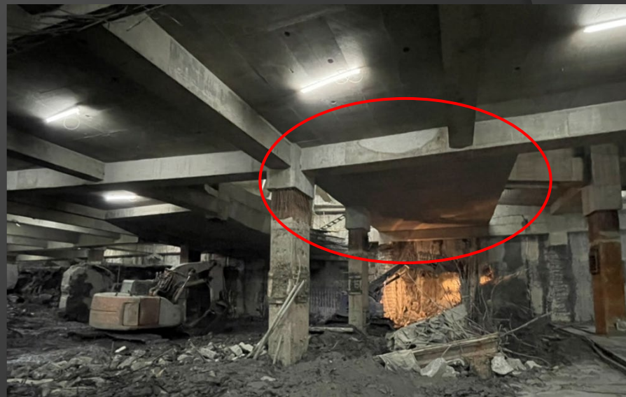
車道假設結構版安全支撐
