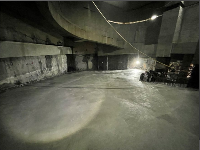
B棟B2F北側車道灌漿後現況 2022.03.02
