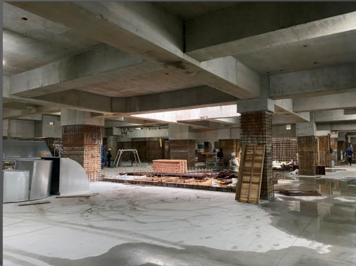
E棟B1F北區二次柱牆施工 2021.12.21
