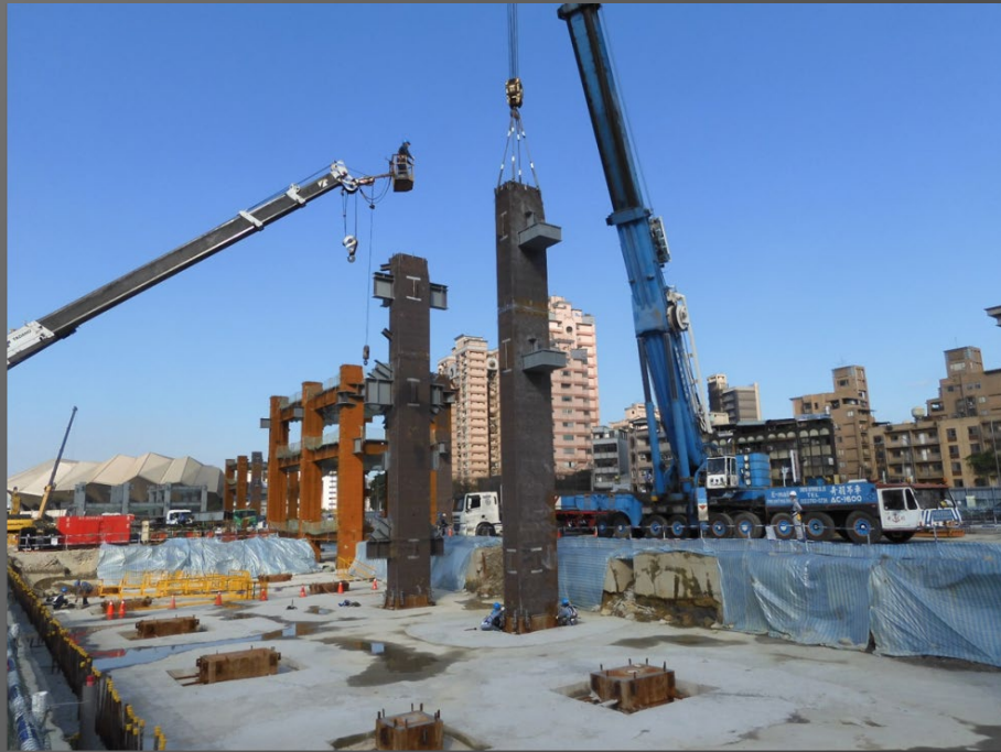
各區鋼構第一.二節吊裝
