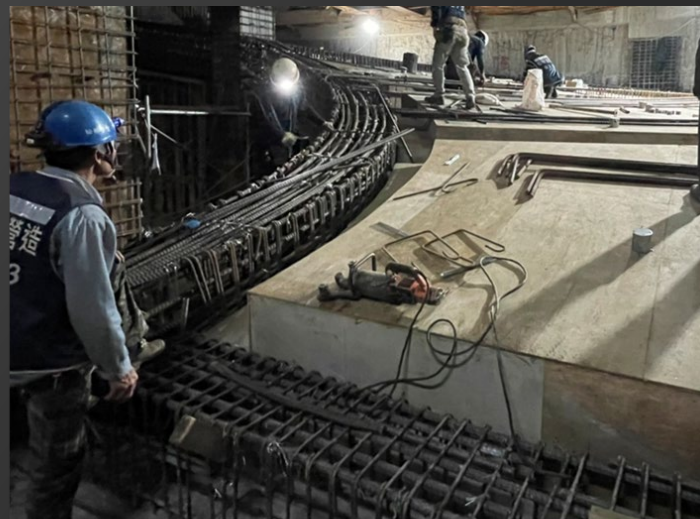
G棟B2F北側車道鋼筋綁紮 2022.04.21
