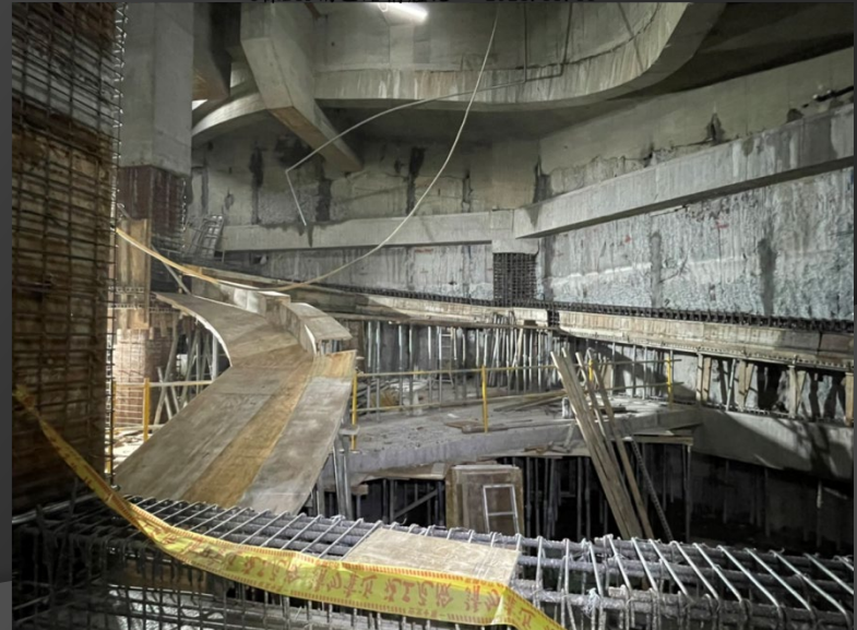
B棟B2F北側結構體施工 2022.02.15
