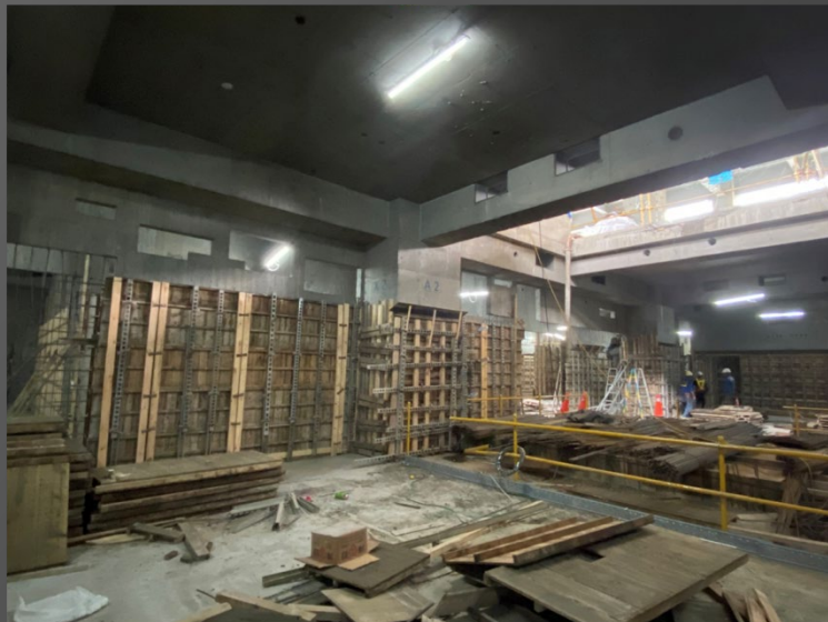
A棟B1F二次柱牆結構體施工 2021. 10. 20
