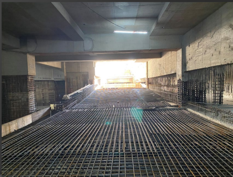
C棟B1FL南側車道區結構體施工 2021.12.03
