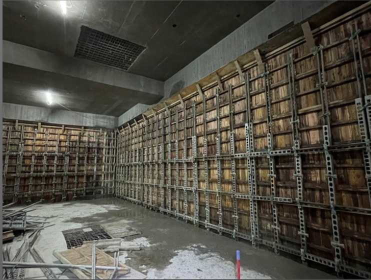
A棟B2F二次柱牆施工 2022.02.15
