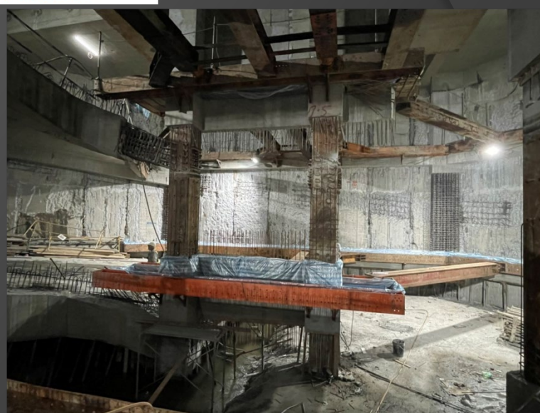
G棟北側第2層水平支撐 2022.03.23
