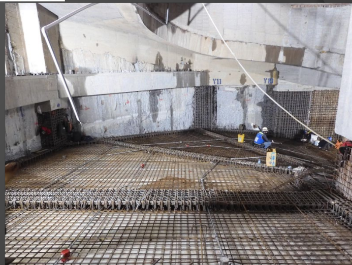
B棟B2F北側車道版鋼筋綁紮 2022.02.24
