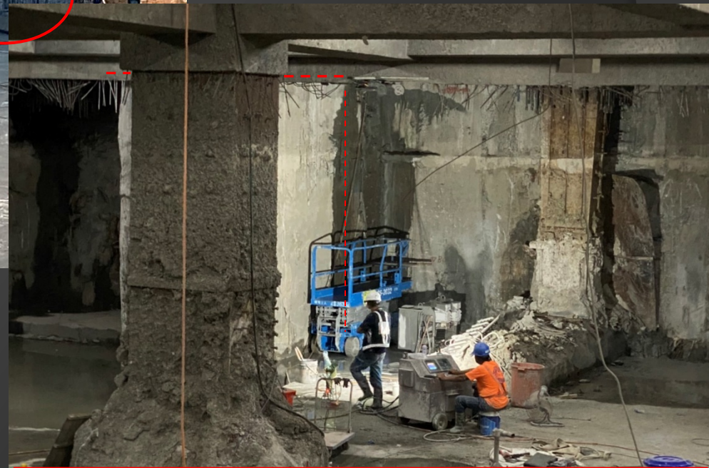
最終開挖25cm4000Psi-PC完成後,進行扶壁切除打除
