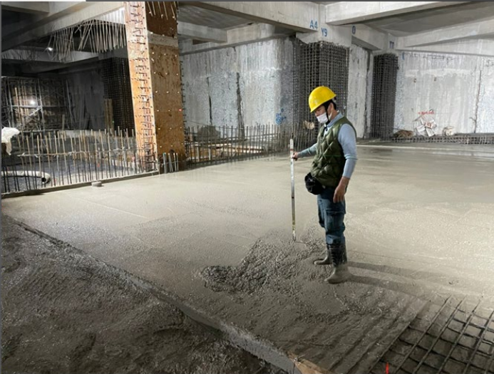
B棟B2F北側灌漿高程檢測 2022. 01. 20
