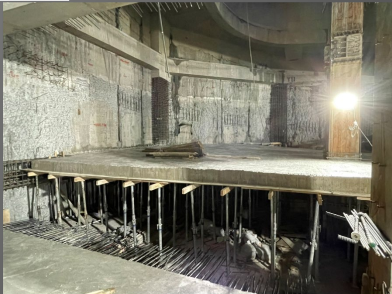
B棟北側假設車道版施作 2022.01.21
