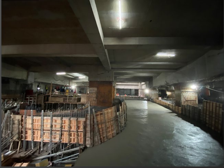
結構體工程： B棟B1F南區結構體灌漿作業 2021.11.23
