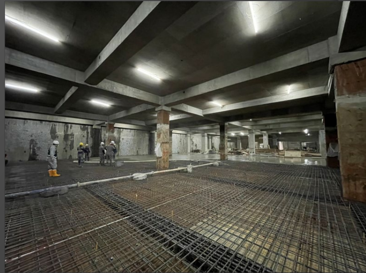
E棟B2F灌漿作業 2022. 05. 16
