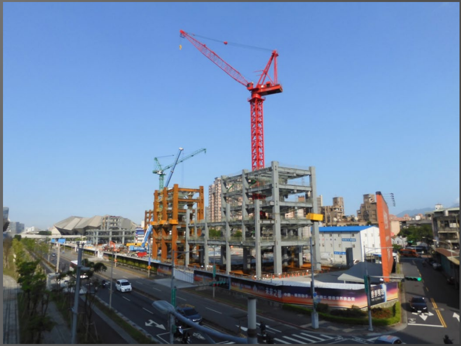
塔吊安裝及遮斷層DECK設置
