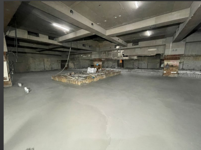
A棟B1F灌漿完成 2021. 10. 02
