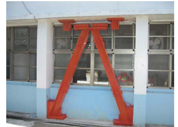
斜撐加裝型式 立面示意圖
