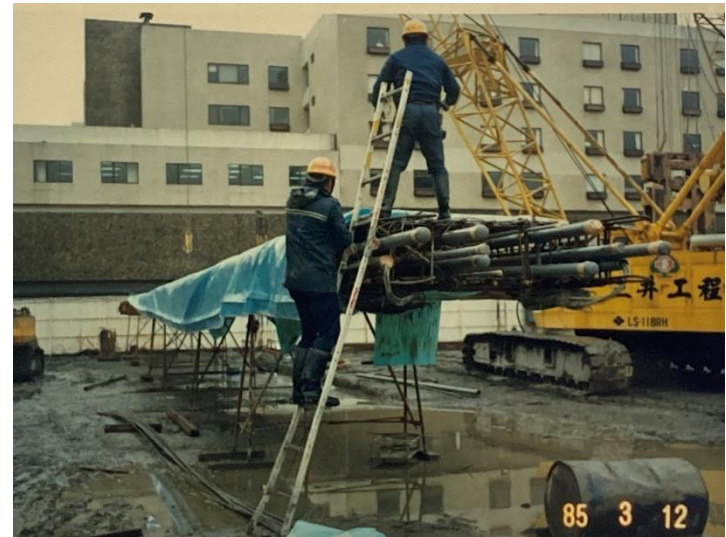
基樁試樁單元之鋼筋籠
