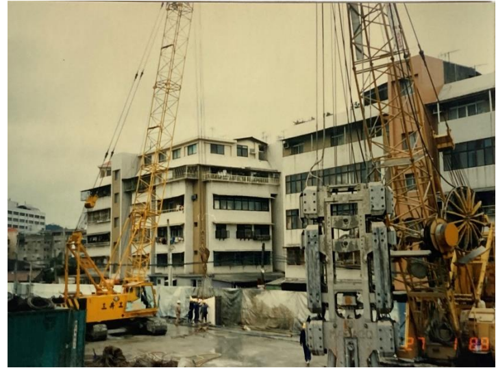
連續壁施工 台灣前五棟日本MASAGO 連續壁挖掘工程
