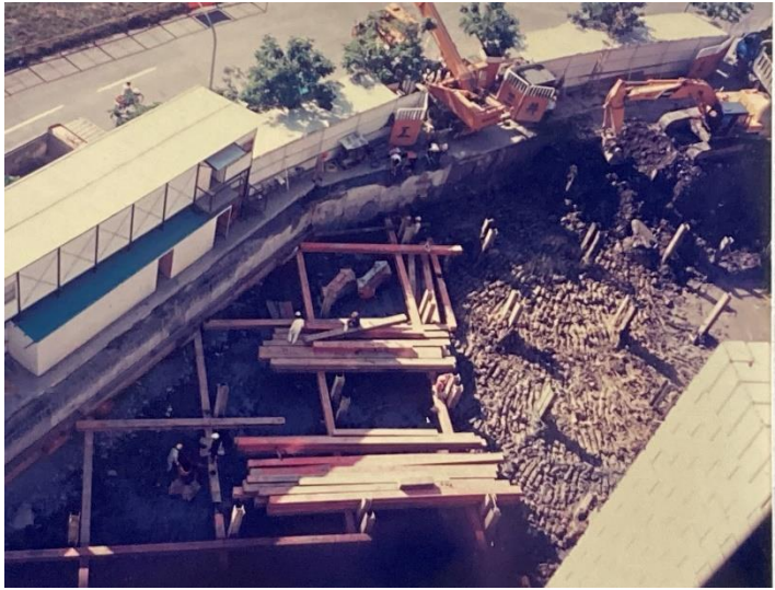
地下室開挖 擋土支撐空照
