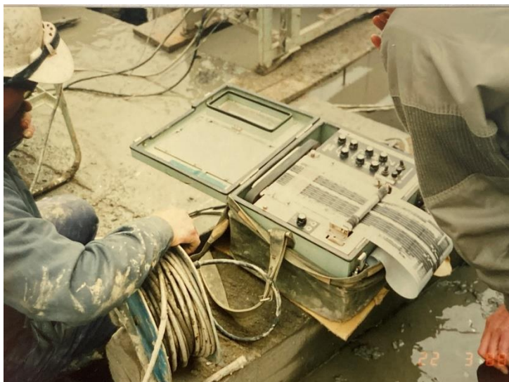
反循環基樁 超音波測量
