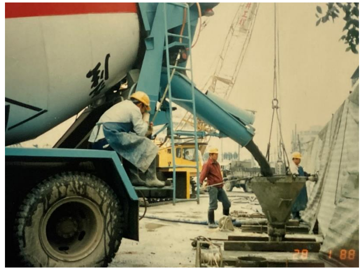
連續壁施工 母單元混凝土灌漿
