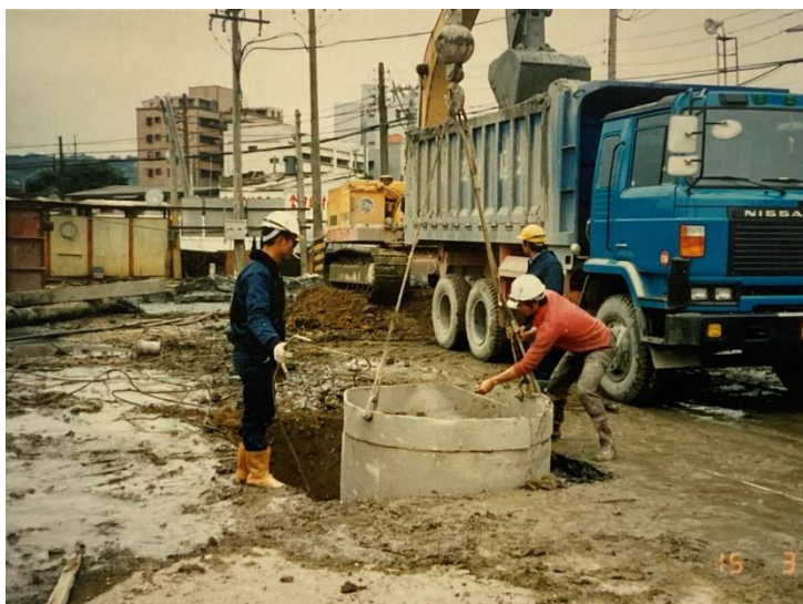
反循環基樁 放樣定位
