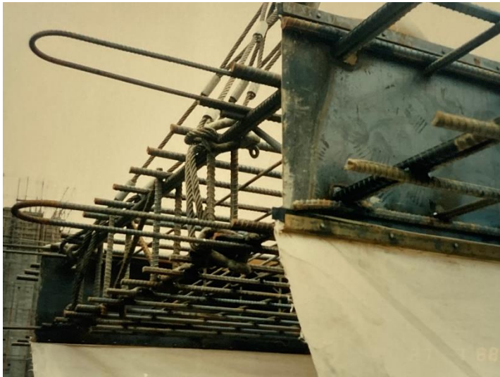
連續壁施工 母單元鋼筋籠組立
