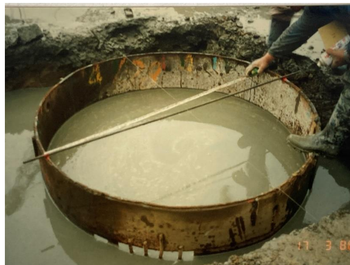
反循環基樁 確認斷面尺寸
