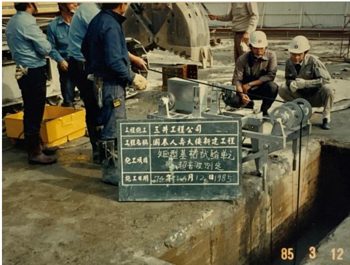
基樁試樁 超音坡
