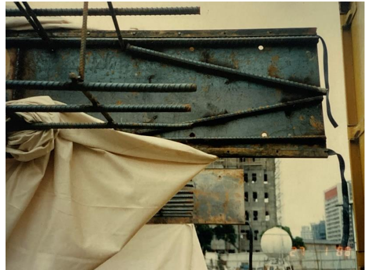
連續壁施工 母單元鋼筋籠端板加深 防止漏漿
