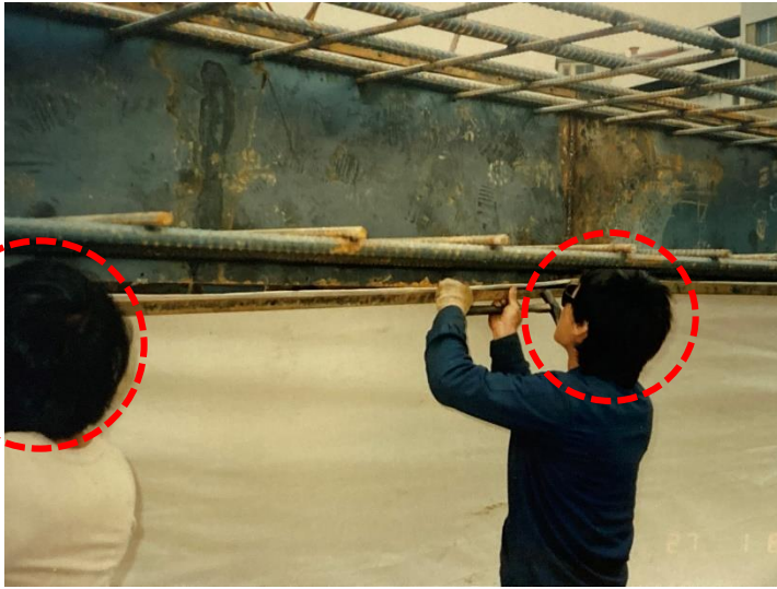
連續壁施工 母單元鋼筋籠端鉸止水鉸與帆布
