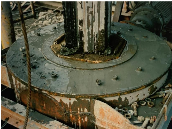
反循環基樁 掘削作業 對工地環境汙染大
