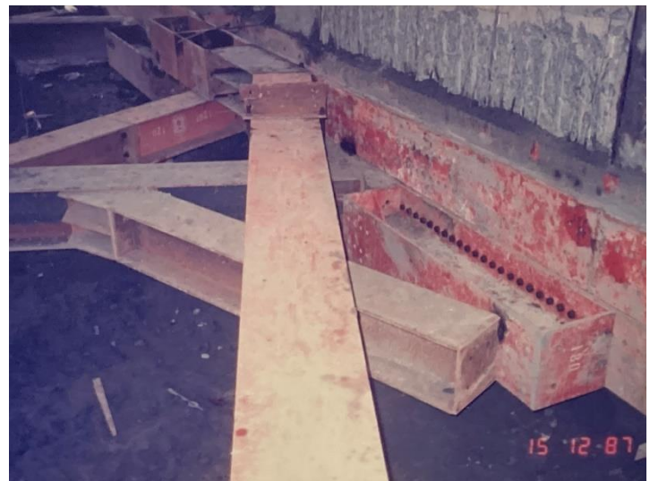
擋土支撐非直接之角隅處落實補強
