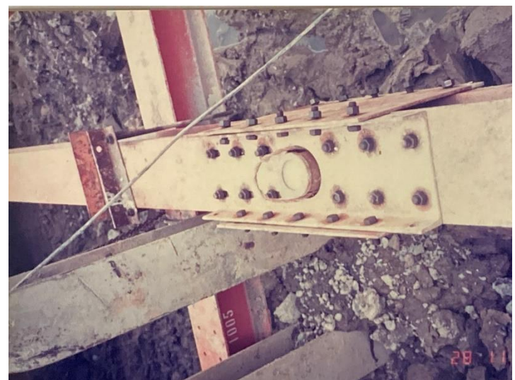
地下室開挖 安全支撐上之土壓計 應力補強
