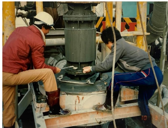
反循環基樁 加拆管作業
