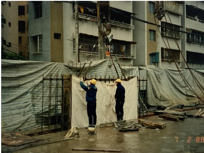
連續壁施工 母單元鋼筋籠吊放
