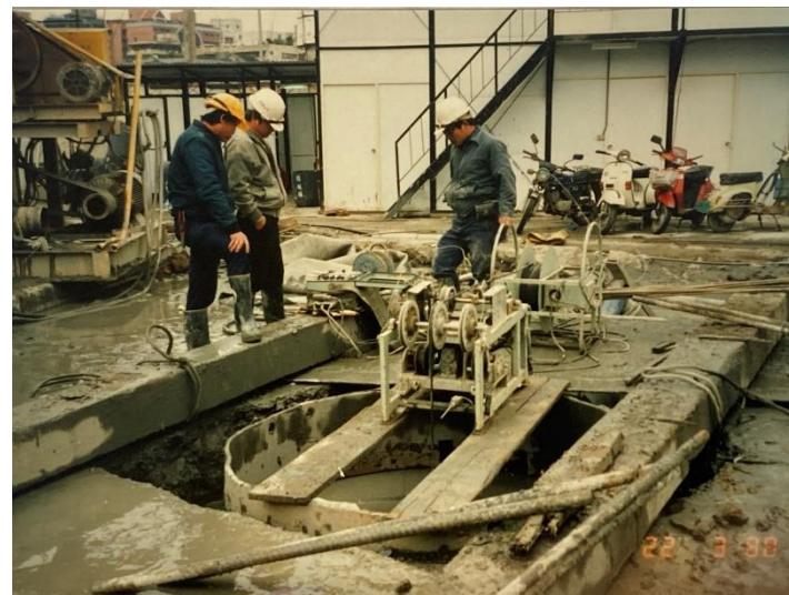
反循環基樁 超音波測量垂直精度與壁體平順度
