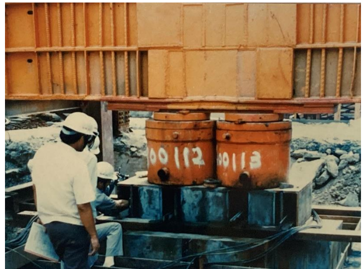
基樁試樁 預力油壓千斤頂
