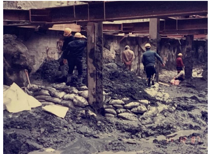
地下室開挖 連續壁接合處包泥 漏漿應變處置
