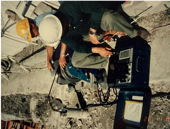
連續壁施工 安全監測<壁體應變計起時值測定
