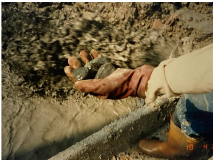
反循環基樁 掘削至承載層 礫石確認
