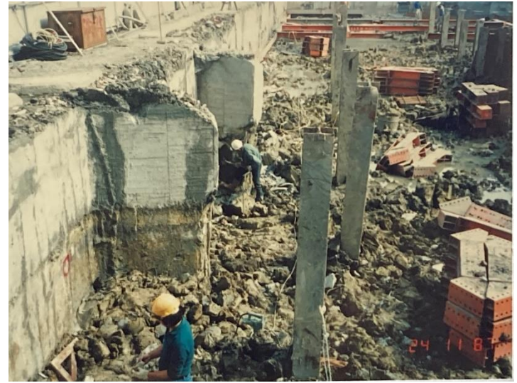
地下室開挖 擋土支撐第一層作業
