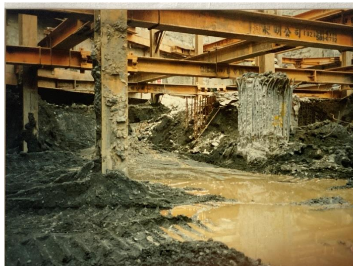
反循環基樁 地下室開挖至大底時之樁頭 與柱梁接合
