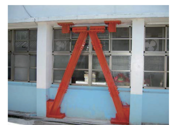
斜撐加裝型式 立面示意圖
