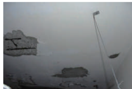
樓板下方混凝土剝落、鋼筋裸露初期混凝土剝落、鋼筋腐蝕裸露嚴重
