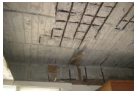
混凝土剝落、鋼筋腐蝕裸露嚴重混凝土剝落、鋼筋腐蝕裸露嚴重
