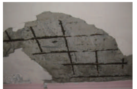
混凝土剝落、鋼筋腐蝕裸露嚴重混凝土剝落、鋼筋腐蝕裸露嚴重
