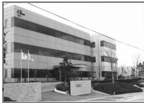
照片二 日本松村組技術研究所
