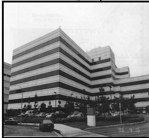
美國南加州大學醫院(積層橡膠隔震器)
