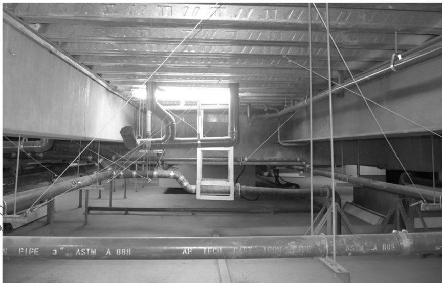
隔震建築物配管示意圖
