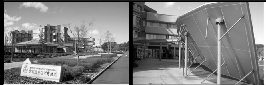
宮城県立兒童醫院 3月11日震度6強 / 3月12日餘震戶外停車棚倒塌
