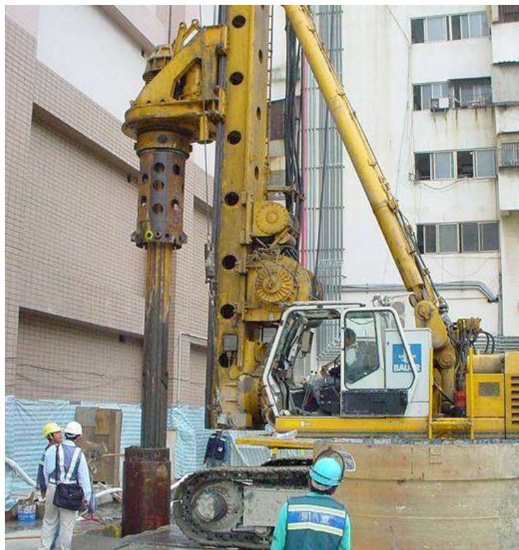
土鑽套管鑽機德國寶峨BG-30型
