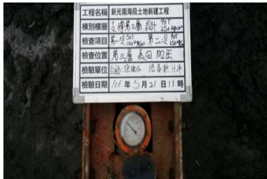
▲ 支撐加壓施作檢查
