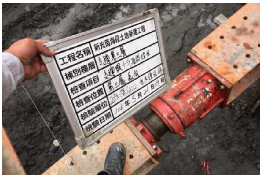
▲ 加壓前千斤頂螺栓檢查
