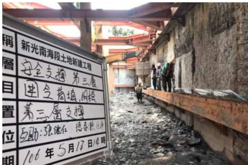
▲ 圍苓背填混凝土
