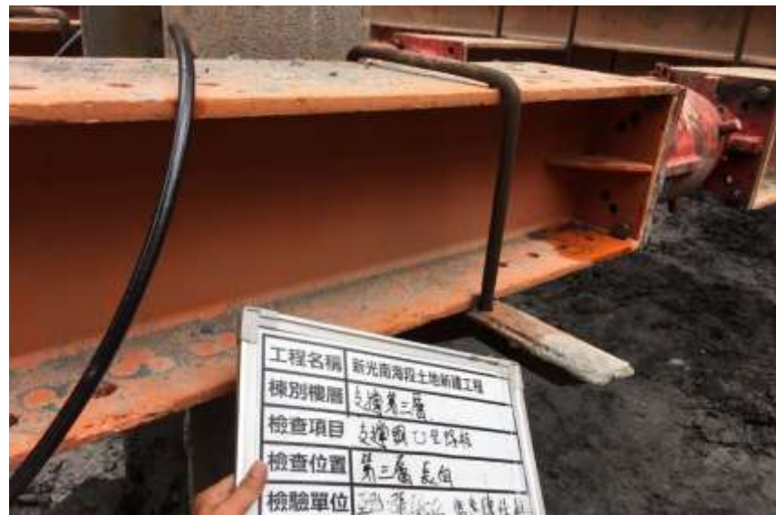
▲ 加壓前U型螺栓檢查
