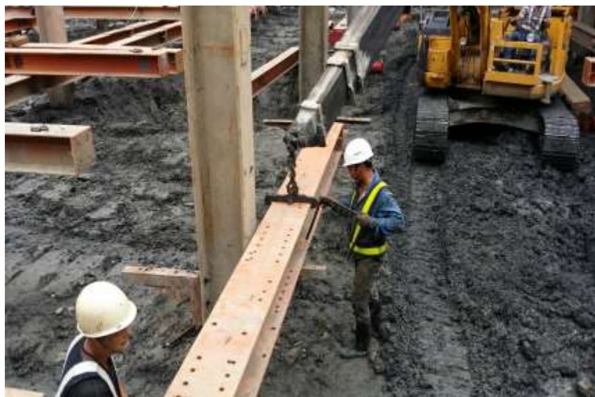
▲ 支撐組裝架設
