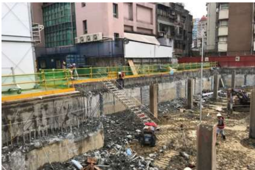
▲ 三角架高程測量檢查
