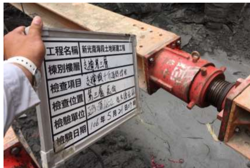
▲ 加壓前千斤頂螺栓檢查
