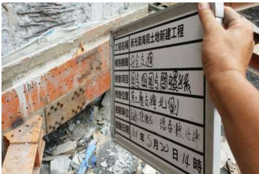
▲ 圍苓與支撐間螺栓檢查
