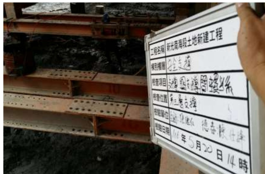
▲ 加壓前支撐間螺栓檢查
