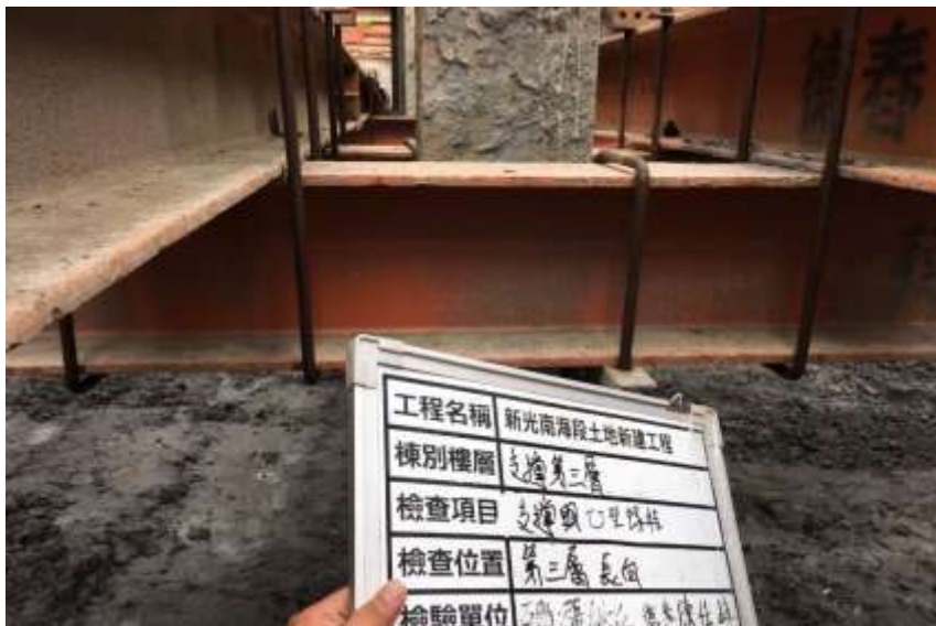
▲ 加壓前U型螺栓檢查
