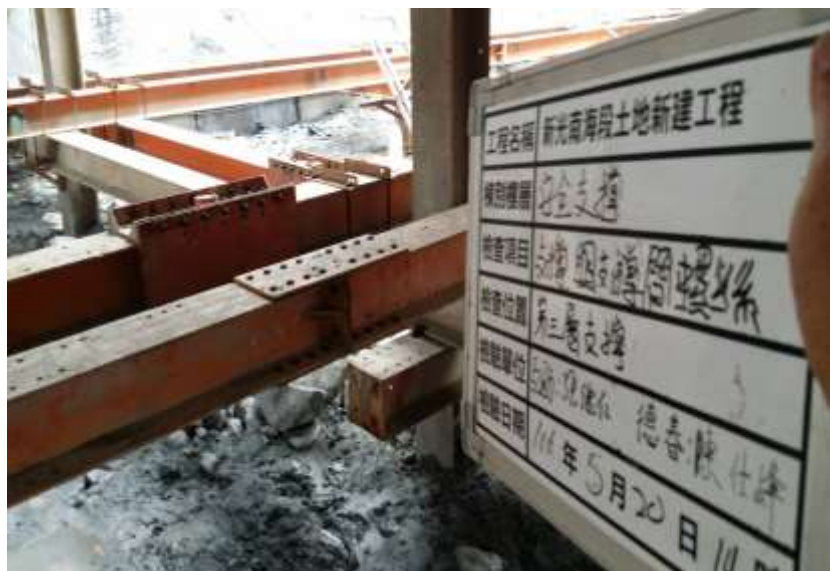
▲ 加壓前支撐間螺栓檢查
