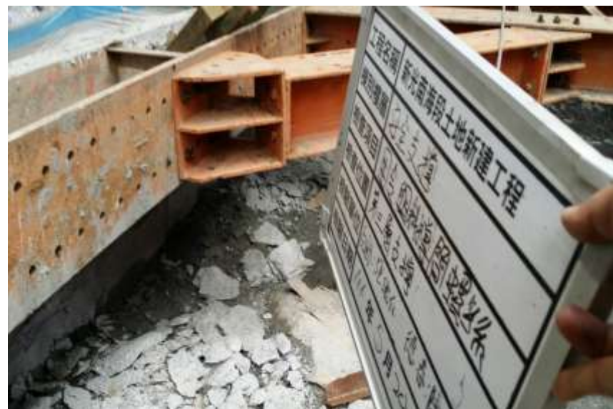
▲ 圍苓與支撐間螺栓檢查
