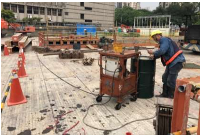
▲ 支撐加壓施作檢查
