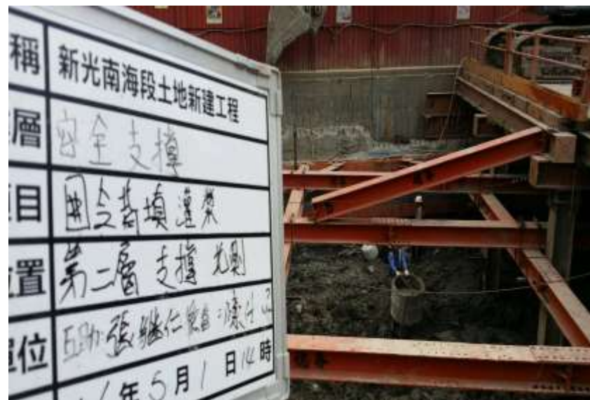
▲ 圍苓背填混凝土
