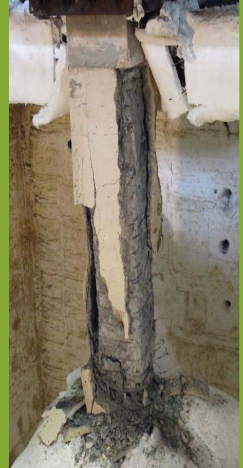
RC柱火害修補後再火害
