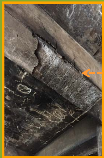
預測7~900 °C處 混凝土剝落狀況
