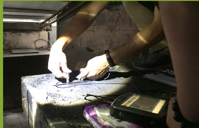
火害現場非破壞檢測
