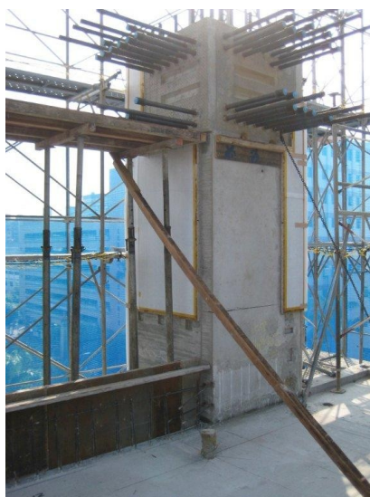
(2)實際梁柱接頭施工圖
