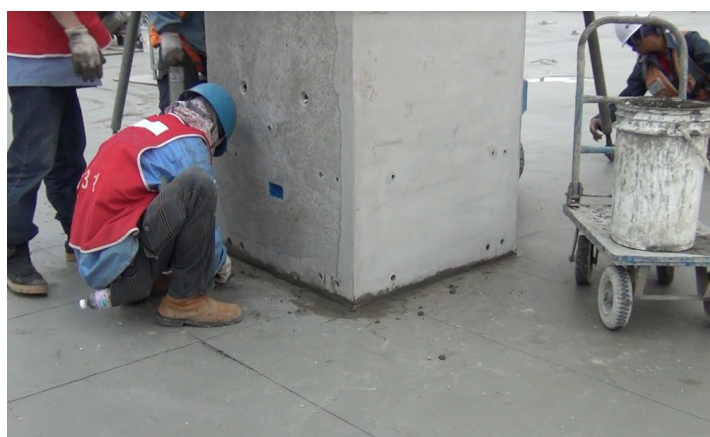
圖 R8.12 預鑄柱續接套筒與柱底接縫同時灌注填充料之範例 [8.4]
