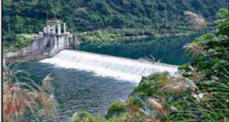
粗坑壩 (水利署)
