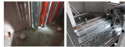
圖 3 回填式降板構造配管 圖 4 無回填式降板構造配管
