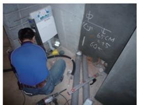
圖 10 牆前構造配管施工
