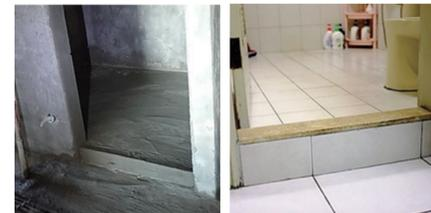
圖 7 回填架高構造配管
