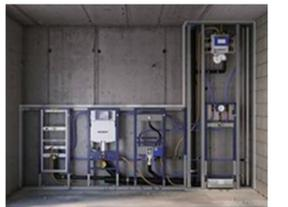
圖 9 牆前構造配管施工
