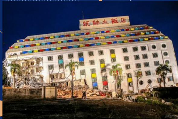
統帥大飯店傾斜、塌陷
