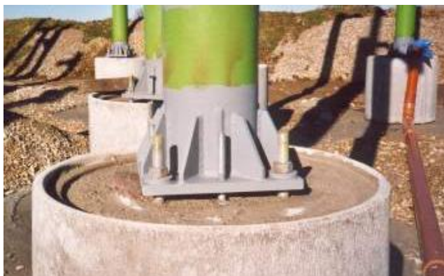
鋼結構(柱)錨固
