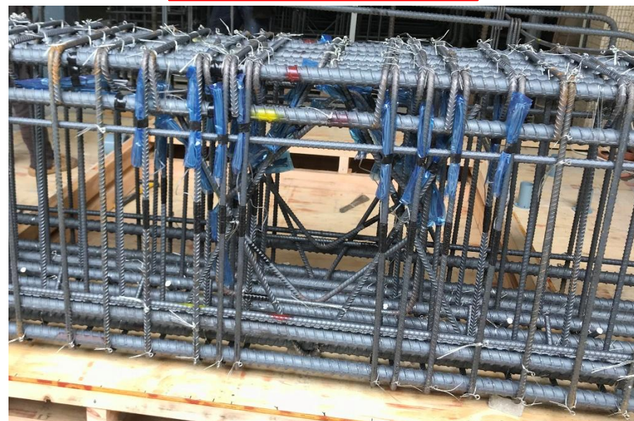
試體西面朝下時之鋼筋實際綁紮情況
