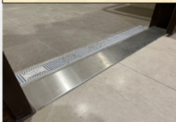
浴廁出入口 不銹鋼排水槽
