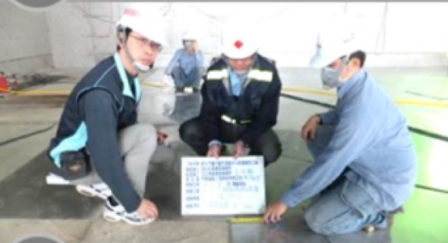
4 池底 鋼板搭接 查驗
