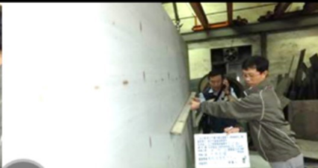
2 池壁 鋼板平整度 查驗
