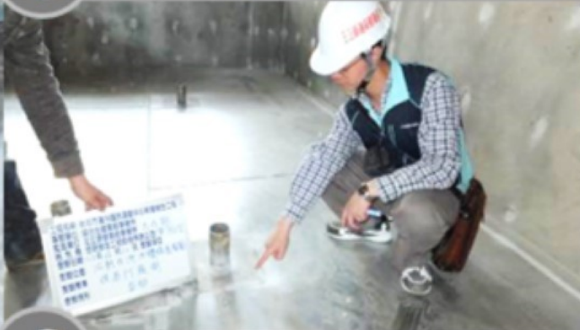
8 管路 穿版焊道 檢驗
