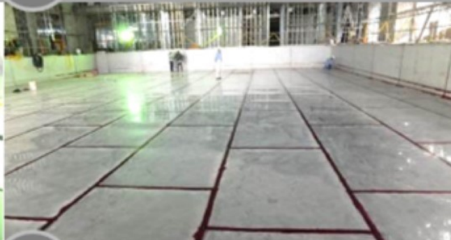
5 池底 鋼板滿銲 無變形
