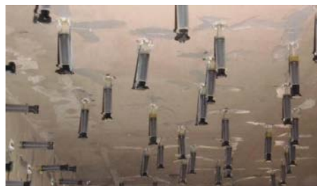
EPOXY裂縫注射工法
