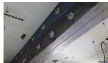
鋼板補強工法
