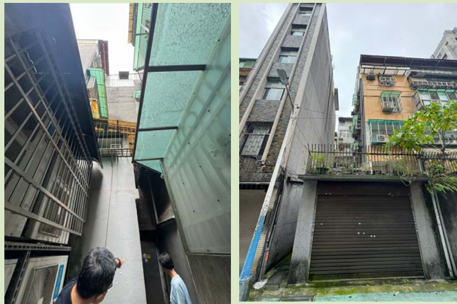
施工路徑不足
