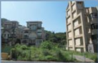
重建前空地 設計暨圖片提供：林祺綿建築師事務所
