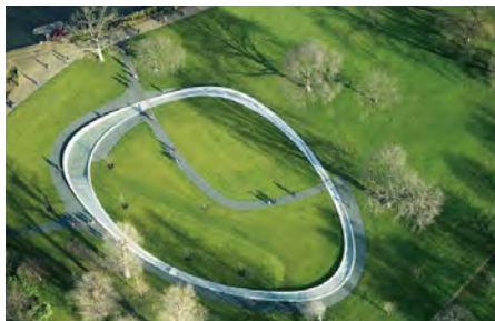
水-屋頂薄層綠化吸收雨水涵養
