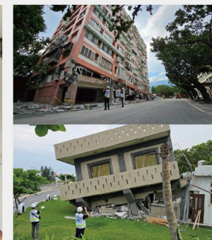
圖8 403地震花蓮鹽寮民宿破壞照片
