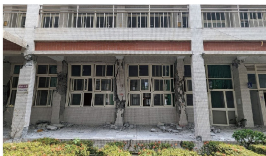
圖4 403地震花蓮女中校舍破壞照片
