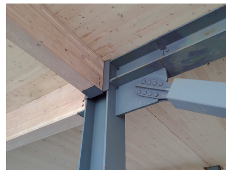
木構造與鋼構造的接合鐵件。
