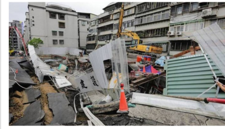
大直基泰工地
