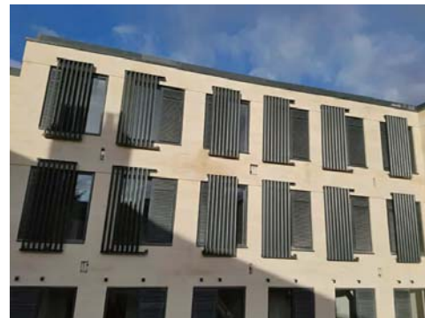
用[孔隙總距離]除以[窗戶寬度]計算
