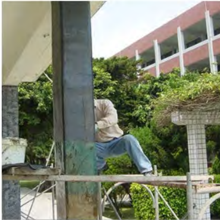
碳纖維補強工程
