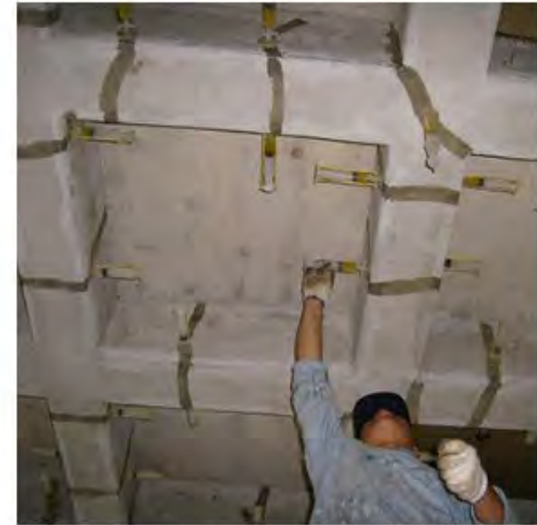
裂縫灌注工程
