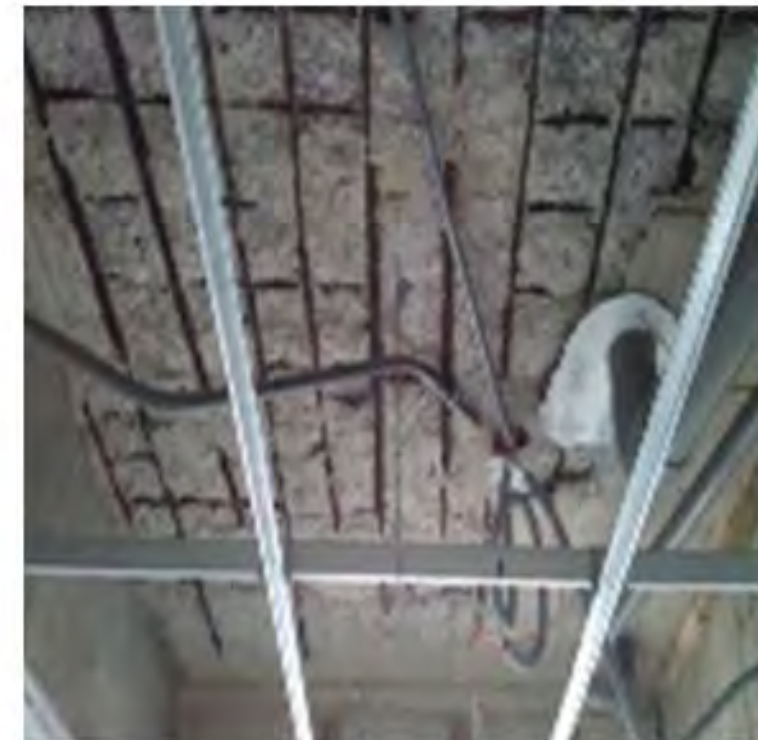
混凝土中性化處理
