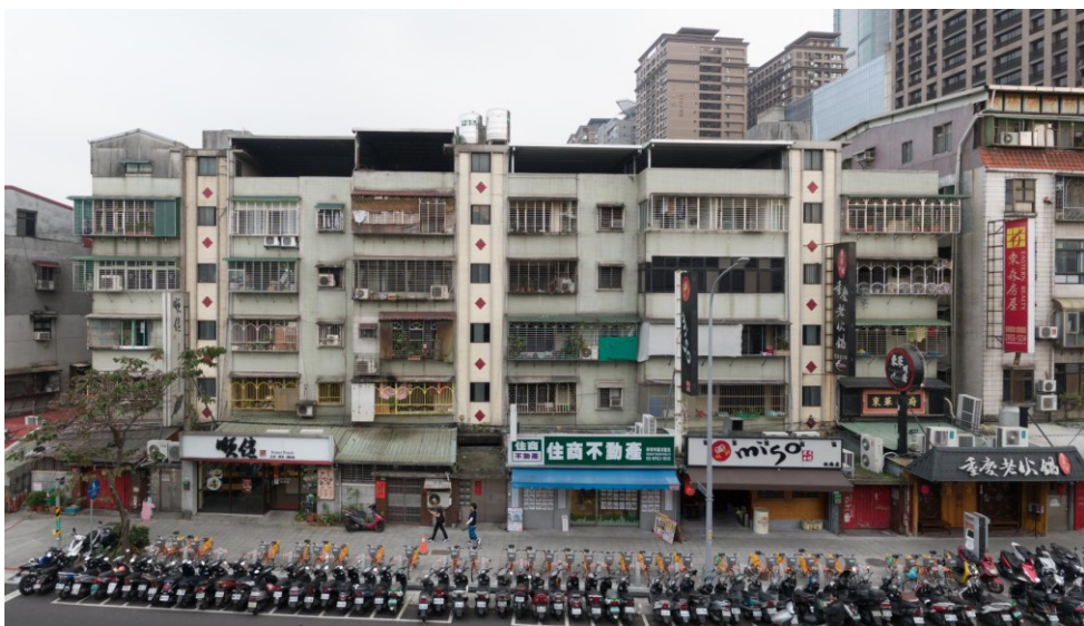
漢生東路街口示範標的施工前照片
