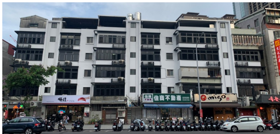
漢生東路街口示範標的施工後正面照片
