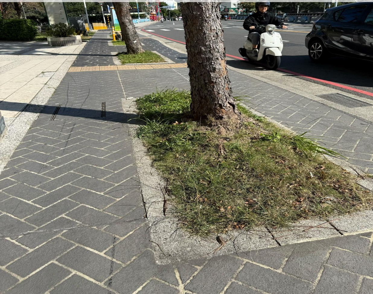
元化路二段-北側 ( 有 使用樹穴結構 面層保持完好)2024
