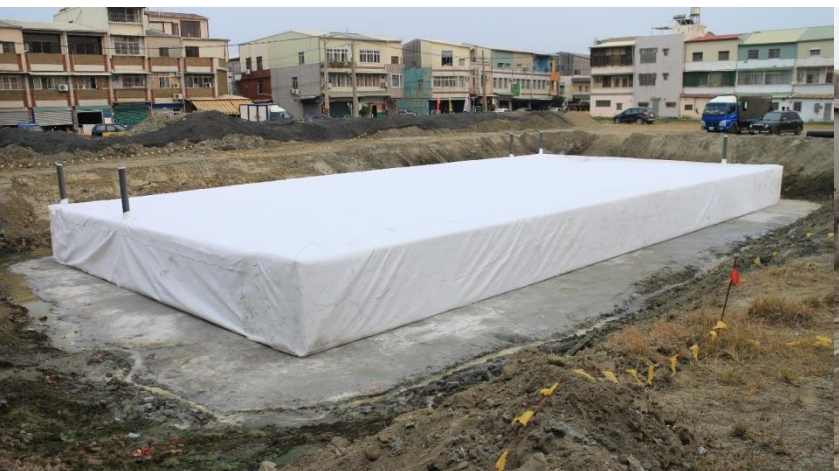
貯留槽包覆保護地工織物
