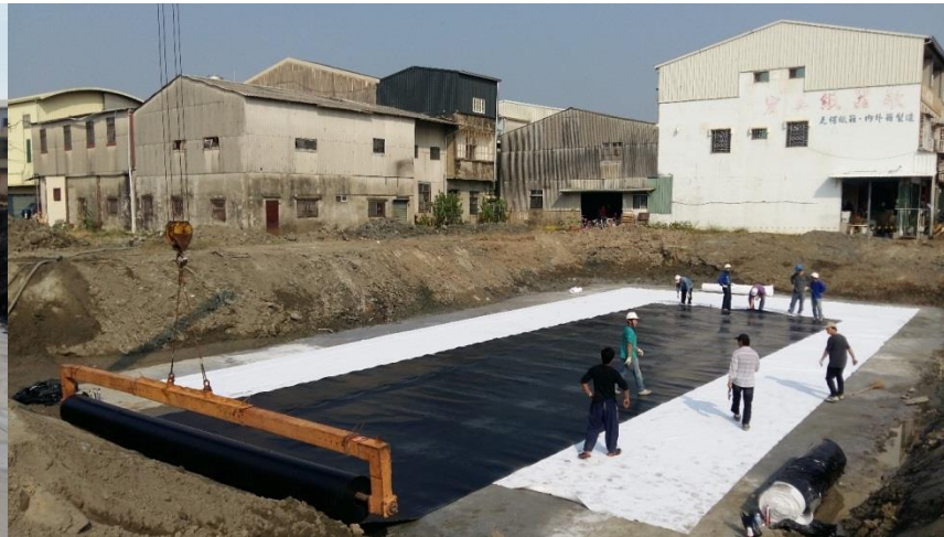
鋪設地工合成材料
