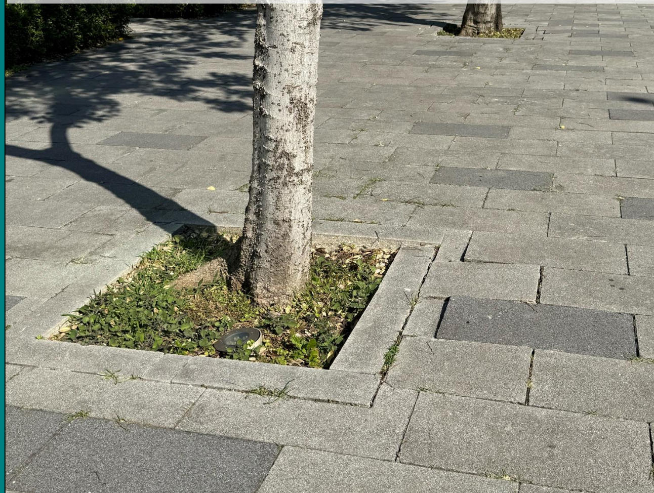
元化路二段-南側 ( 無 使用樹穴結構 面層已開始浮根沉陷)2024
