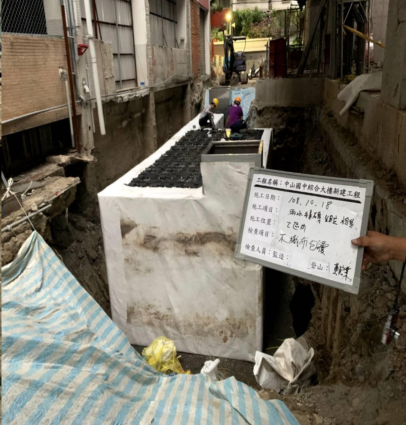
台北市中山國中綜合大樓新建工程/2019 364立方滲透型/銀級綠建築/北市流出抑制
