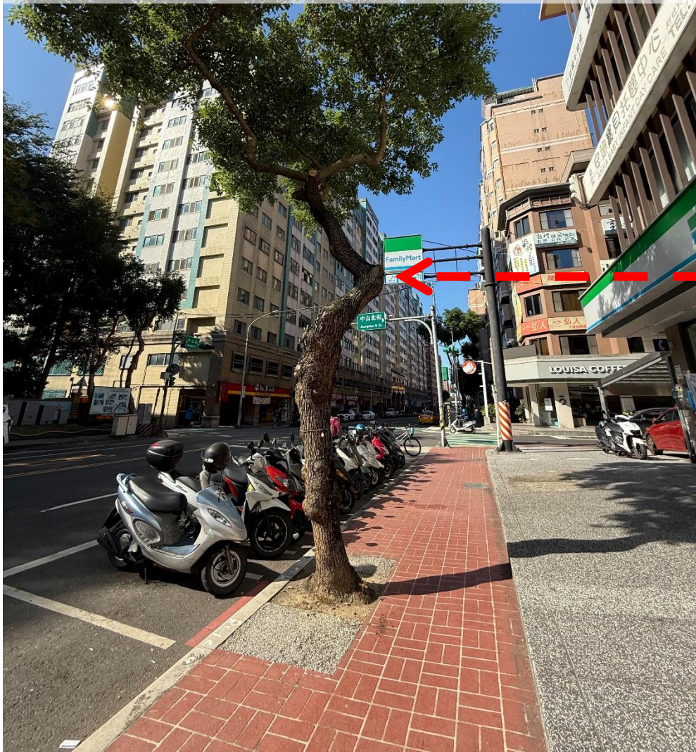
桃園中正路人行道 有 使用薄層樹穴 面層現況保持平整良好狀態
