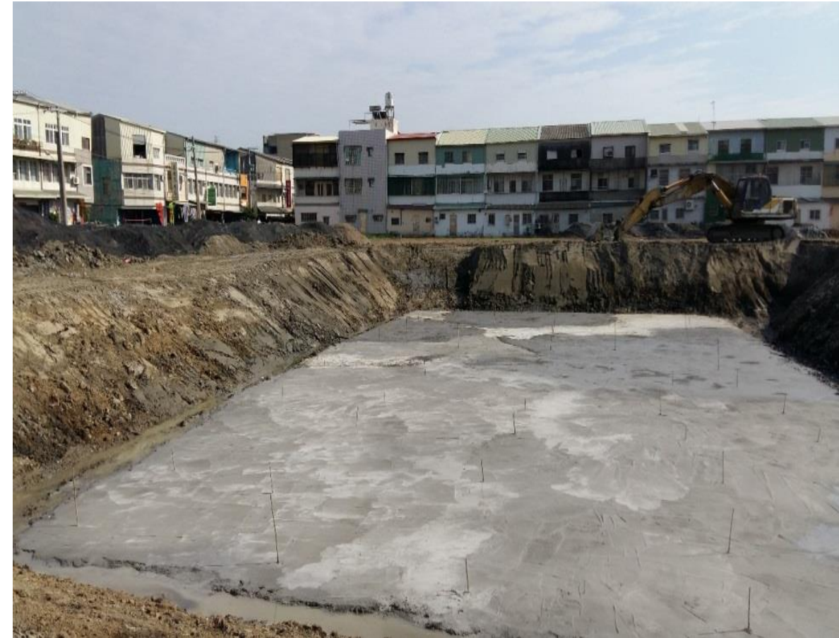
貯留型 PC 打底高度 15公分 (以地質條件做調整)
