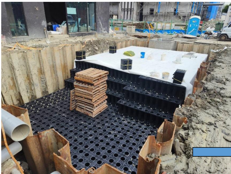
麥當勞-內湖舊宗段得來速新建工程/2023 170立方滲透型/鑽石級綠建築/北市流出抑制
