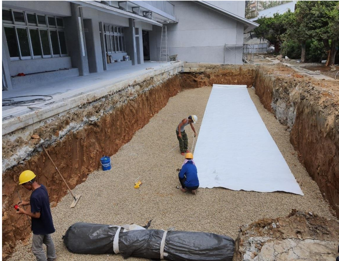
滲透型需三分碎石打底高度 10-15公分
