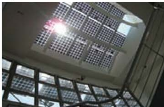
圖 14 透光型BIPV（建築屋頂）
