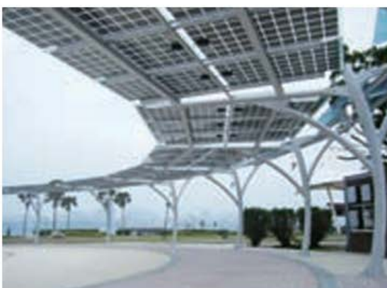
圖 14 透光型BIPV（建築屋頂）
