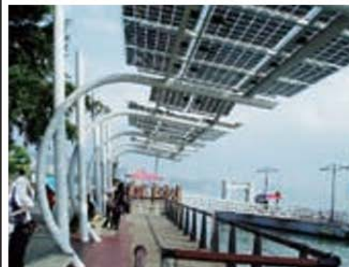
圖 15 透光型BIPV（光電棚架）
