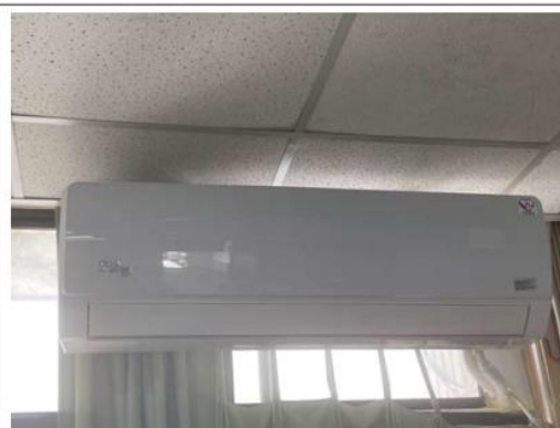
視聽教室個別空調室內機安裝情況
