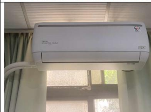
健康中心個別空調室內機安裝情況
