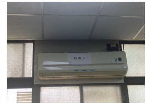
健康中心個別空調室內機安裝情況
