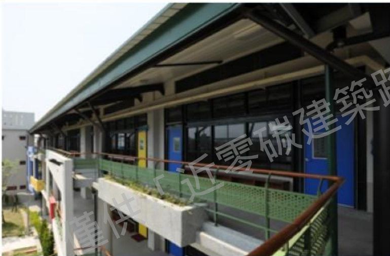
屋頂採RC+鋼構屋頂隔熱處理
