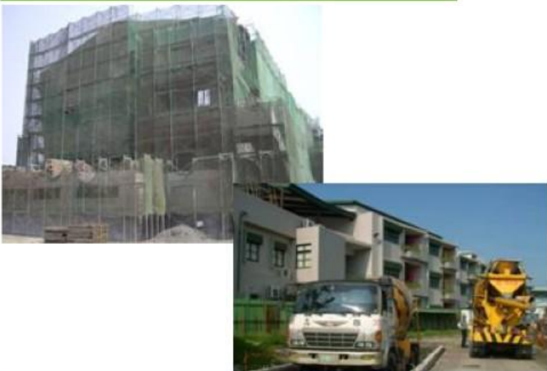
工地防護網、清洗污泥設施，避免環境污染
