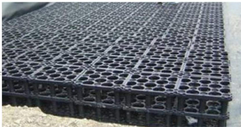
地下礫石層與組合式蓄水框架的地下貯集滲透工法
