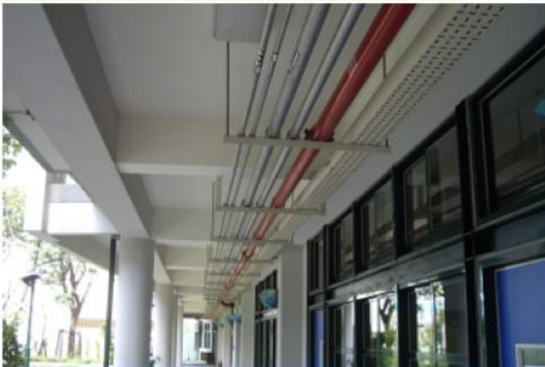
管路設備以懸空結構支撐
