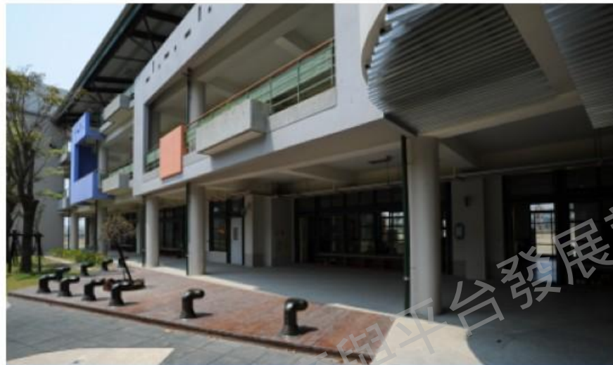
走廊雨水管採明管設計
