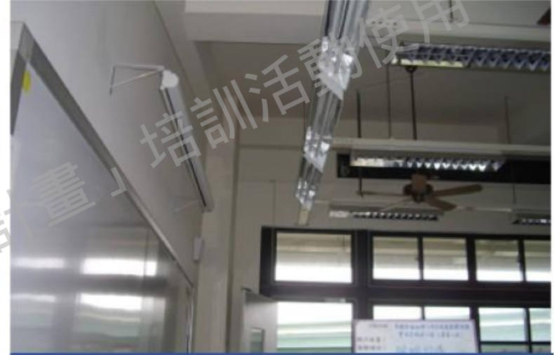
具鋁製反射鏡之節能崁燈
