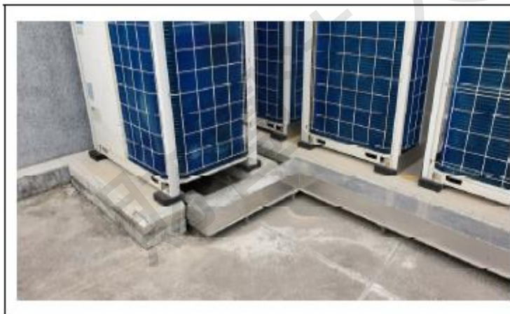
屋頂空調主機下方設置混凝土墩照片
