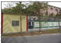
廚餘處理場及曝氣設備
