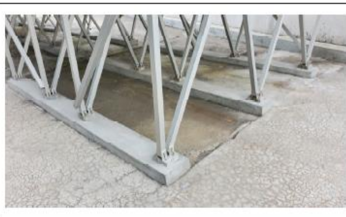
屋頂太陽能板下方設置混凝土墩照片
