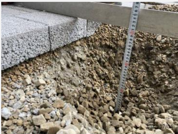
Q2透水鋪面基層厚度施工照片
