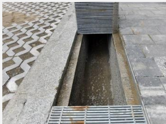
Q8滲透側溝完工照片
