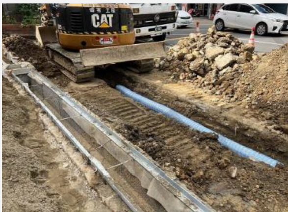
Q8滲透側溝施工過程照片
