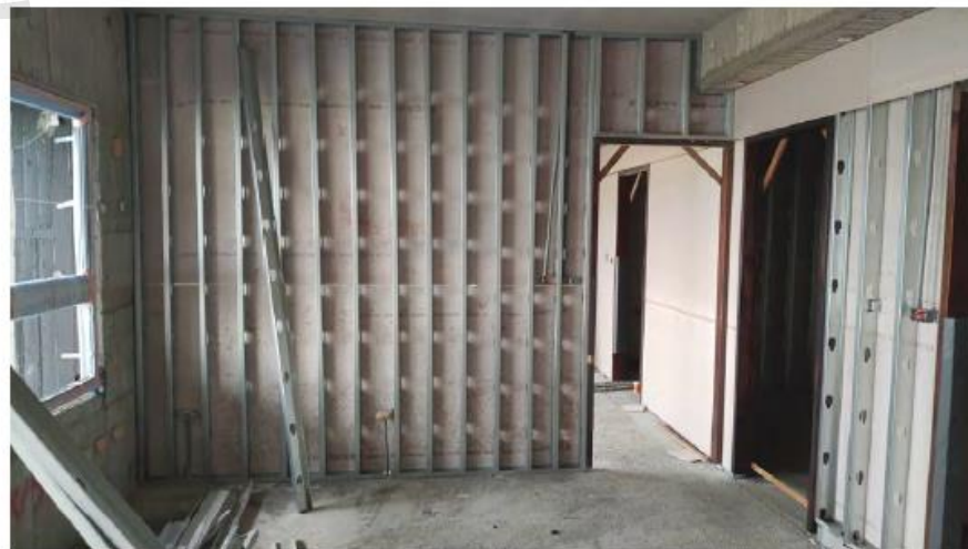
灌漿牆施工中照片-安裝立柱、支撐柱及釘第一面封板
