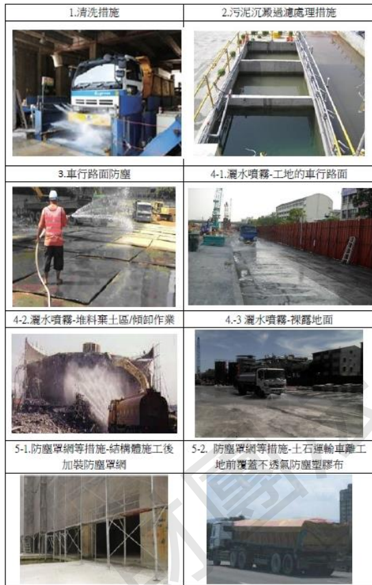
建築工程各項粒狀污染物防制措施示意照片
