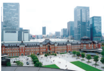
圖2 - 東京車站建築樓層及兩側屋頂已修復成原貌
