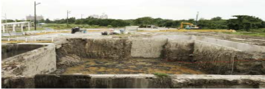
2020.08.21 地坑降挖/ 牆面CCP補強
