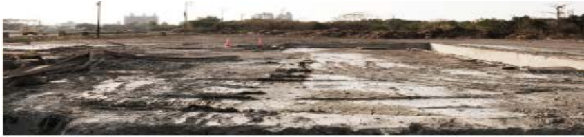
2018.05.05 基地清理，部分挖掘
