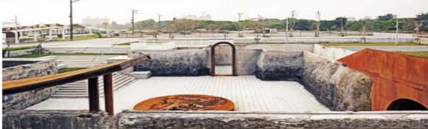
2021.01.26 地坑牆面自行施工、鋼構置入
