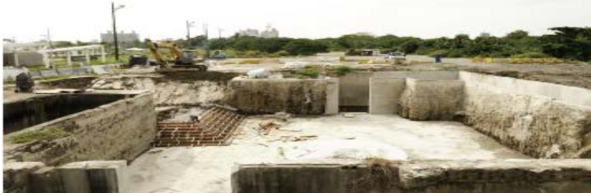
2020.09.26 地坑地面灌漿，階梯泥做施工
