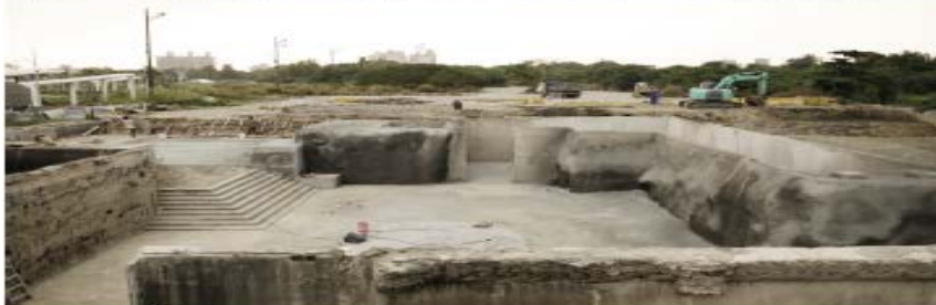
2020.10.26 地坑牆面混凝土噴漿
