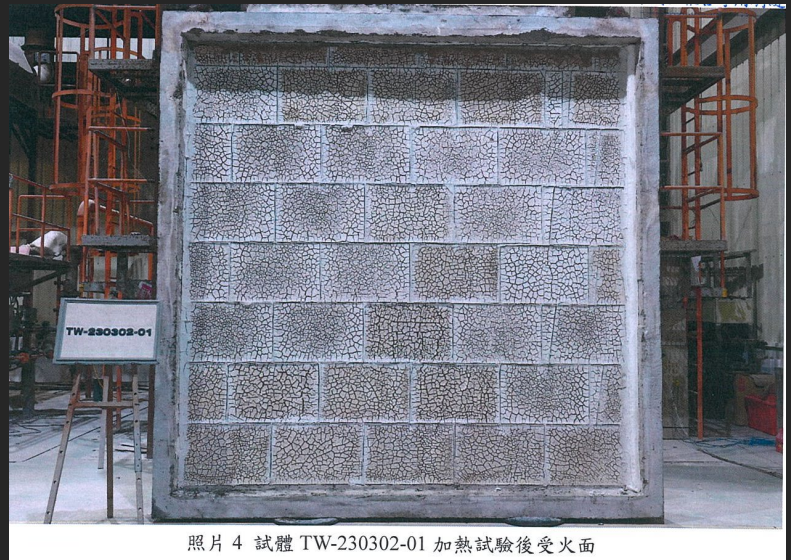
照片 4 試體 TW-230302-01 加熱試驗後受火面
