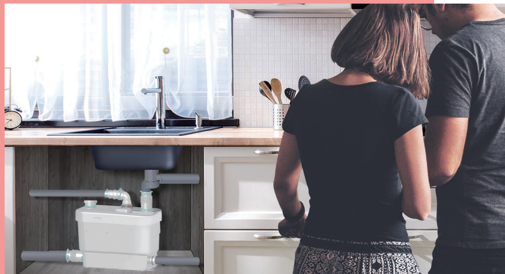
機械式排水解決傳統排水施工限制。
