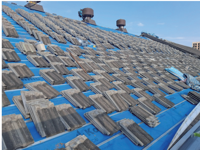
花蓮文創園區目前正在進行 0403 地震後與風災的修復修復工程。
