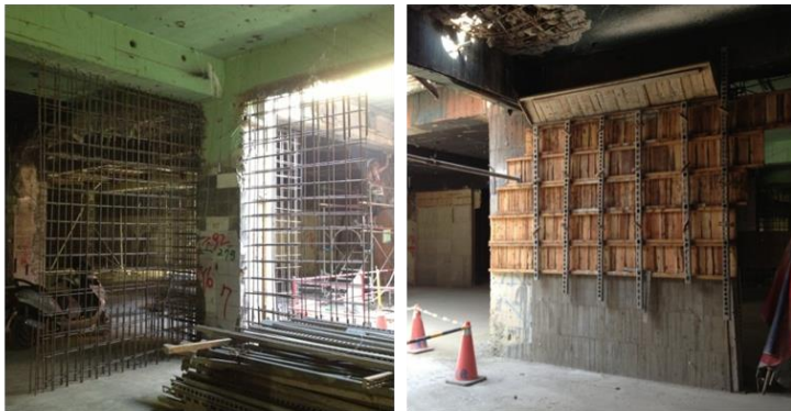
梁下新增翼牆之鋼筋綁紮及拆模完成
