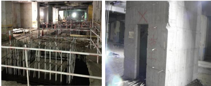
舊樓板破除、井筒鋼筋綁紮及拆模完成
