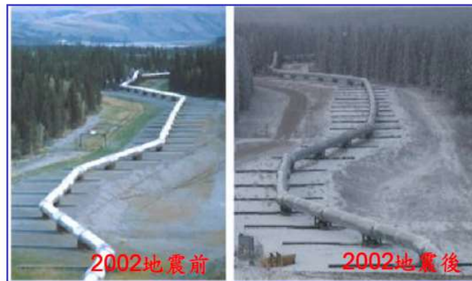
美國阿拉斯加州輸油管線與Denali Fault
