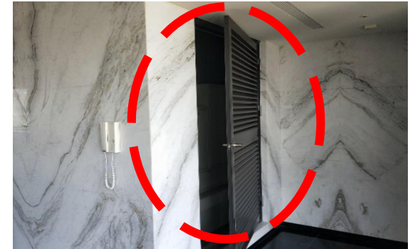
設備開關控制箱不應破壞防火區劃
