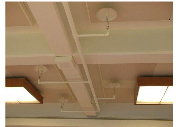
設備開關控制箱不應破壞防火區劃
