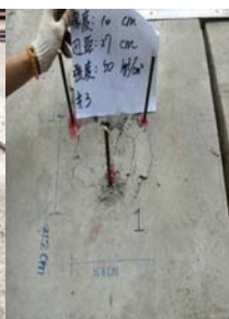
混凝土翹破
