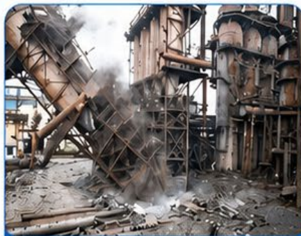
鑄鐵管工廠拆除狀況
