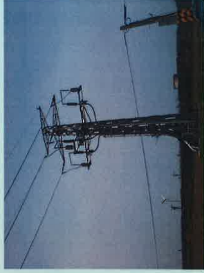
鐵柱型支持物外觀(大部分用於69仟伏)
