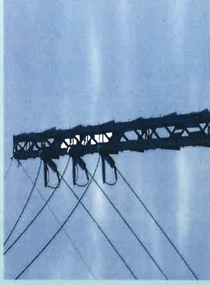
鐵柱型支持物外觀(大部分用於69仟伏)
