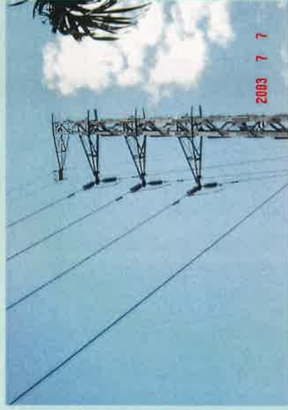
鐵柱型支持物外觀(大部分用於69仟伏)
