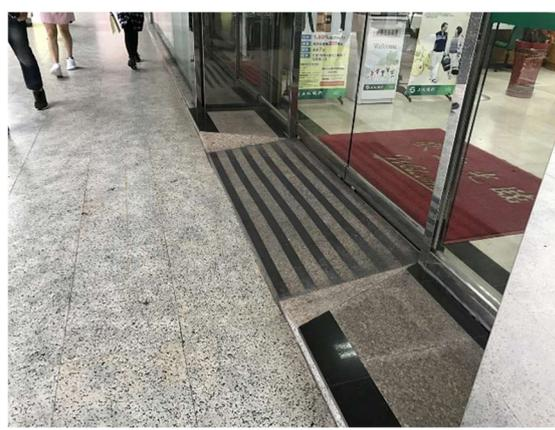
圖5-4 出入口高差採內凹式斜坡處理
