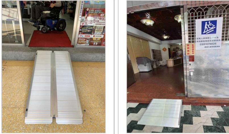
圖 5-20 活動式斜坡板須配合設置服務鈴
