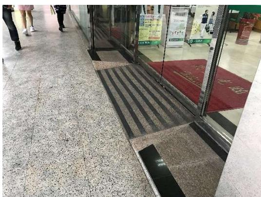
圖 3-13 入口小高差設置內凹斜坡
