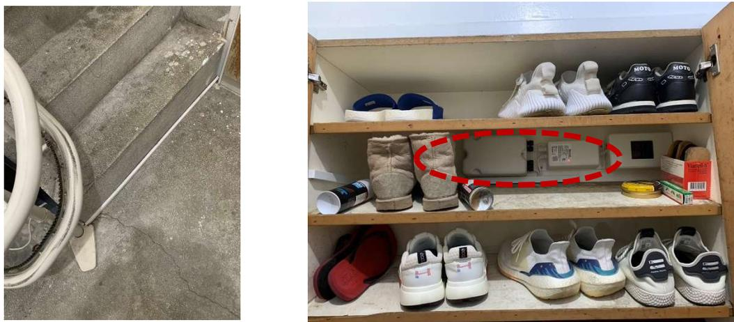
圖3-4 從增設住戶拉電線充電(從鞋櫃第二格處拉線)
