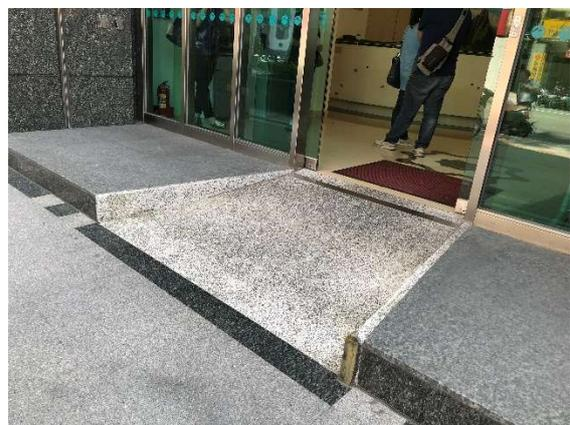
入口高差較小可採內凹式小斜坡方式處理參考圖
