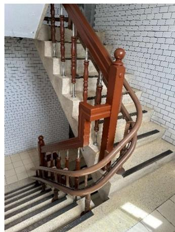
圖3-7 為避免轉彎處軌道突出移除轉角之欄杆支柱
