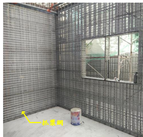
(b) 抓漿網鋪設完成之情況
