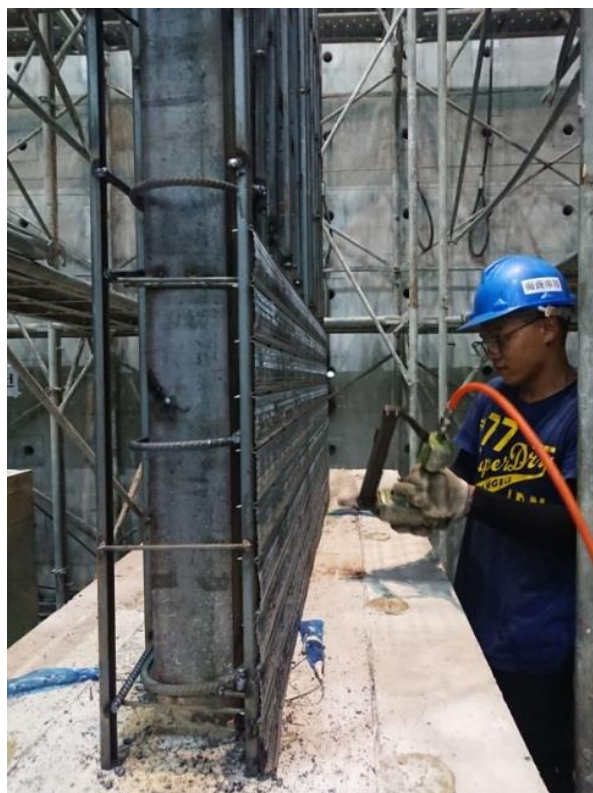
圖 3.15 打設抓漿 (資料來源：本研究製作)
