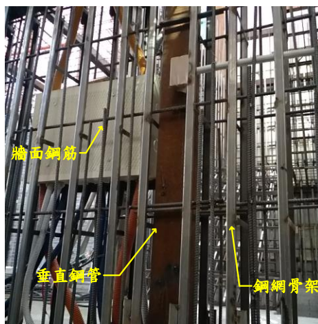
(a) 鋼網骨架及牆面鋼筋配置情況
