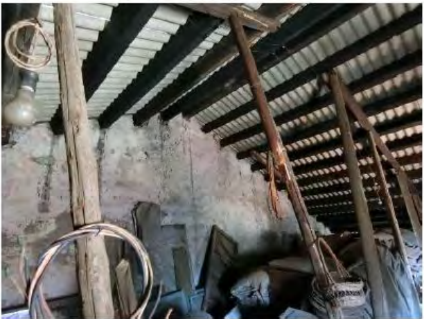
標的物屋頂山牆現況
