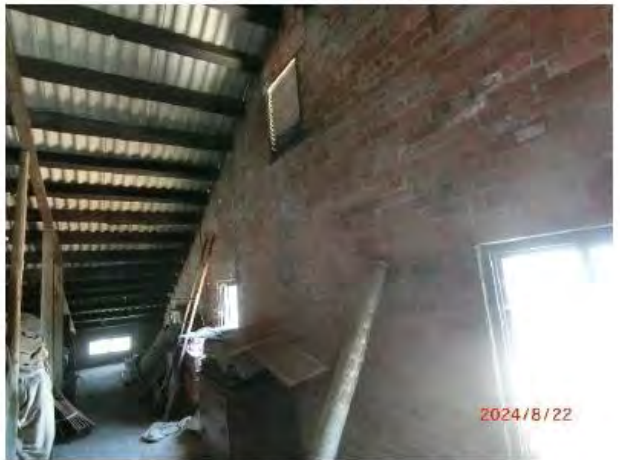
標的物屋頂山牆現況
