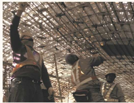
曲牆金屬網模板現場裝設
