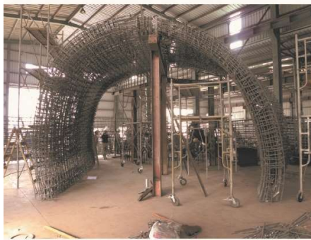
桁架鋼筋及主筋曲牆單元工廠組裝
