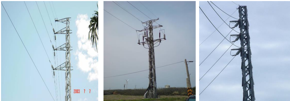
圖 2.6 鐵柱型支持物外觀(大部份用於 69 仟伏)
