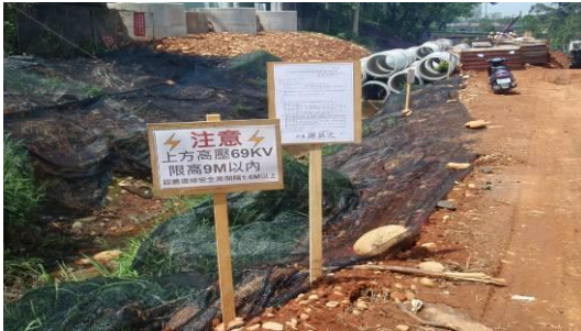
(圖 3) 工地豎立警示牌
