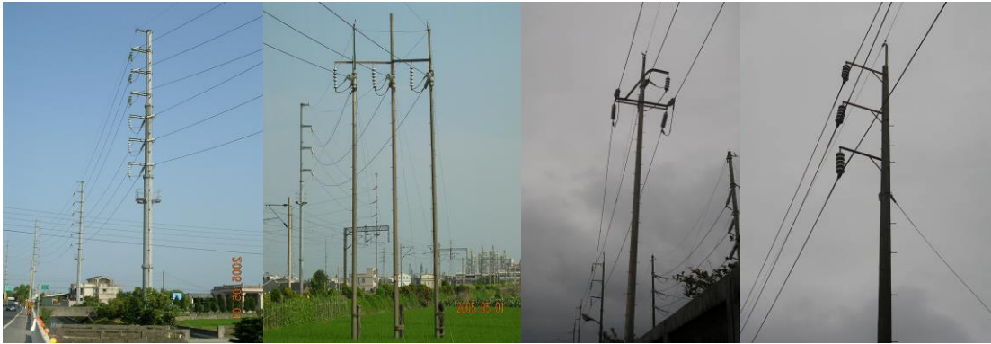
圖 2.5 電桿型支持物外觀(大部份用於 69 仟伏)
